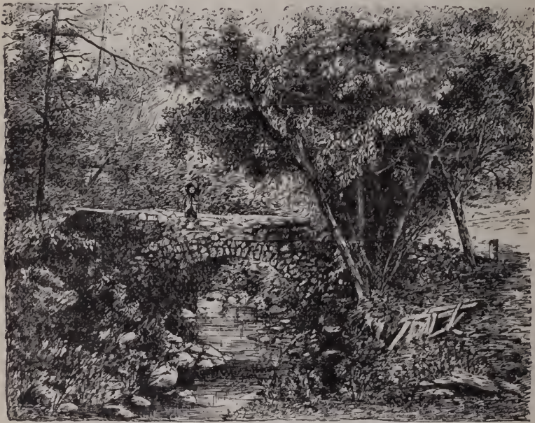
BRIDGE AT EL DESIERTO.
